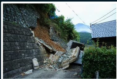
現場映像を遠隔から確認
